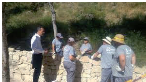
Figura 1. Muros de mampostería.
